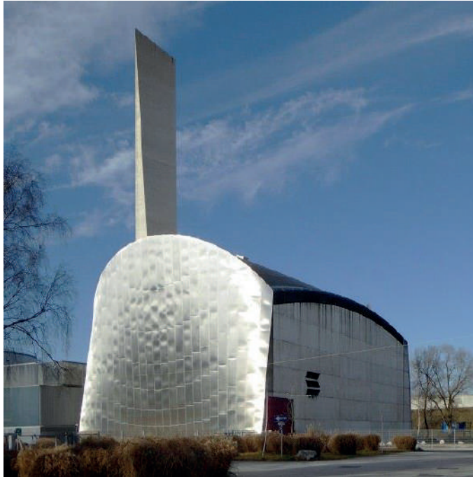
Figura 32. Subestación eléctrica , Betrix and Consolascio Architects, Salzburgo, 1995
