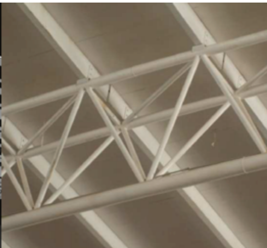
Foto 2. Barras en compresión de armaduras aisladas tridimensionales.
